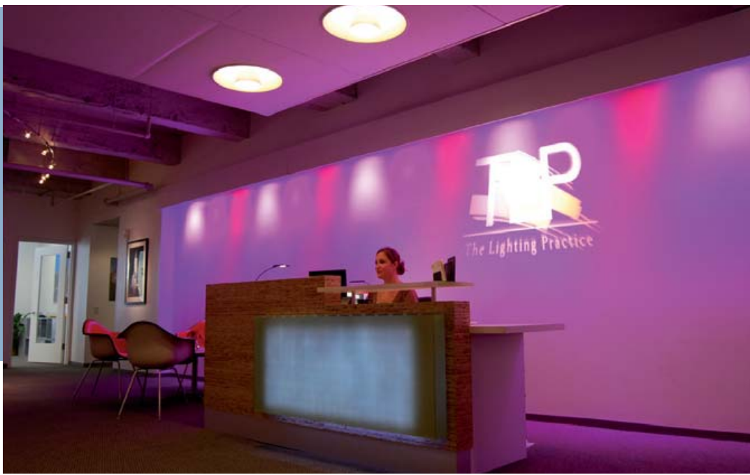
1 - Une agence de design américaine équipée de panneaux de contrôle d'éclairage et de capteurs de présence Watt Stopper
