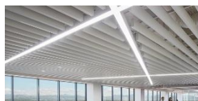
Gérer et optimiser l'éclairage
